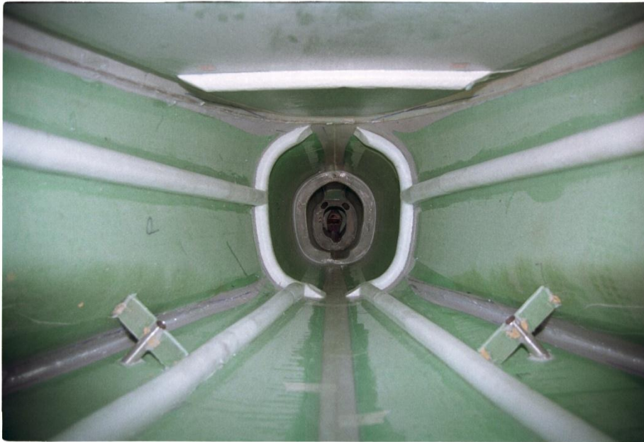
Puolikuorirakenteisen lentokonerungon sisätillaa. Seinämät on vahvistettu liimatuilla pituusjäykisteillä ja muotokaareilla (taaempänä). © Nils Rostedt 2008.
